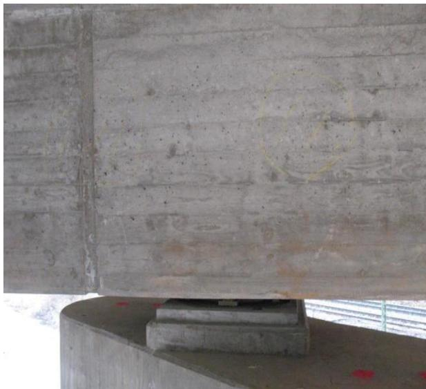
Bei einer H 1 - Prüfung konnten an diesem Neubau an den Seitenflächen der Stege durch visuelle Prüfung keine Schäden entdeckt werden.
