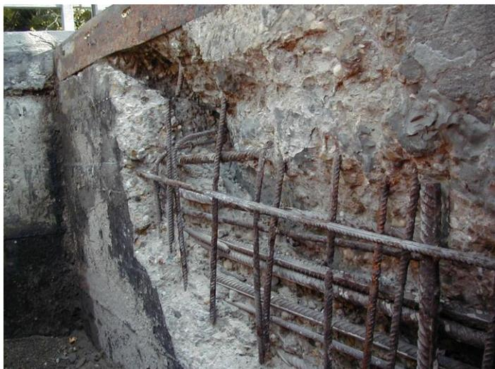
**Bild 2.** Schadstelle an der Kammerwand
