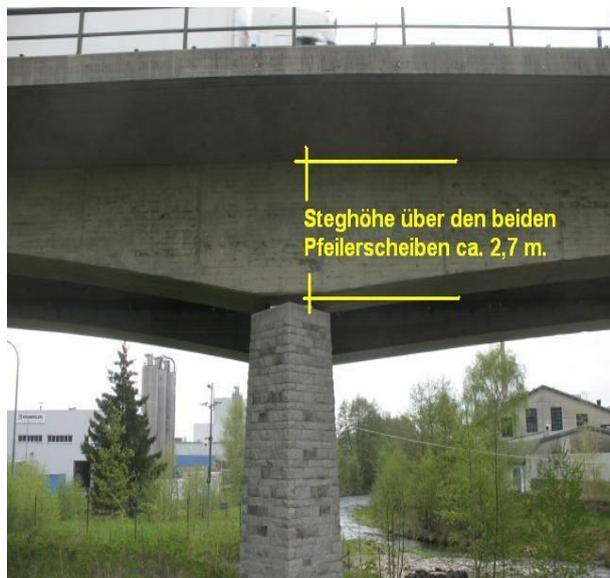
Bei diesem Bauwerk wurden die Grobkornstellen wahrscheinlich noch vor der Abnahme oberflächlich verputzt. Offensichtlich erfolgte keine akustische Prüfung, weder bei der Abnahme noch während der H1-Prüfung durch den Auftraggeber.
